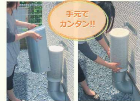
〈屋外給気口のメンテナンス時〉
