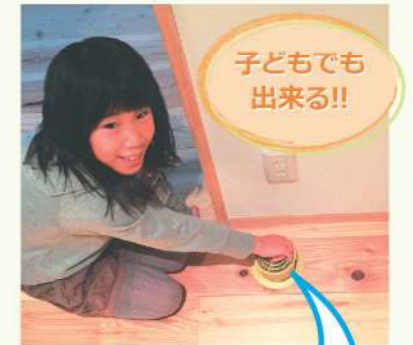
〈室内排気口のメンテナンス時〉
